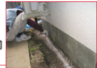
コンクリート基礎
