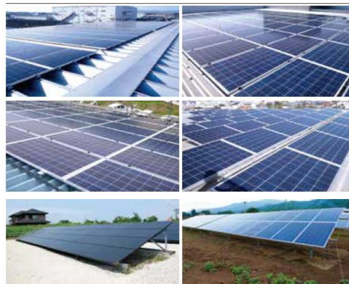
当社工事完成写真一例
