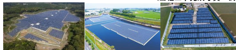
(当社工事完成写真一例)
