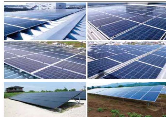
当社工事完成写真一例
