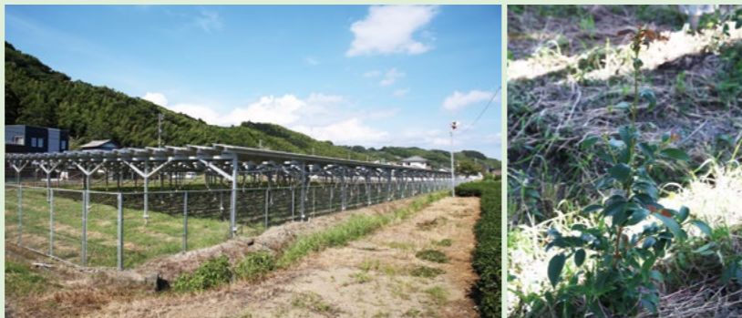
GPエナジーEの営農用太陽光発電所。太陽光パネルの下ではサカキを栽培
