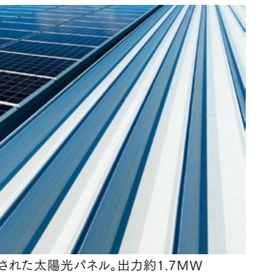
ソニー子会社の倉庫に設置された太陽光パネル。出力約1.7MW
