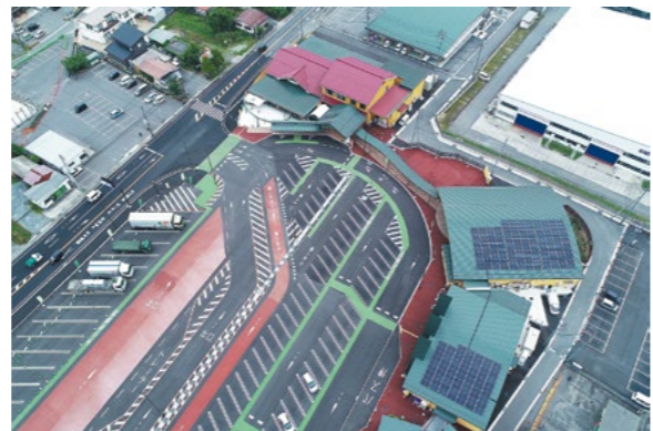
レストラン棟と休憩情報発信棟には出力70kWの太陽光パネルを設置
