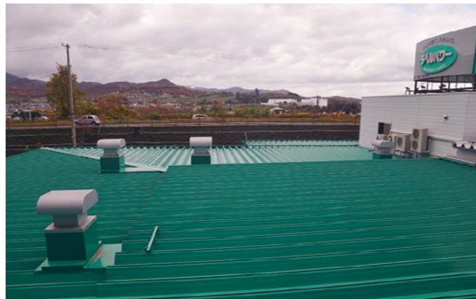
太陽光パネルを設置予定の、進和ラベル印刷本社工場屋根
