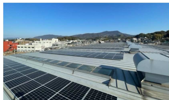
佐世保車両センター屋根上
